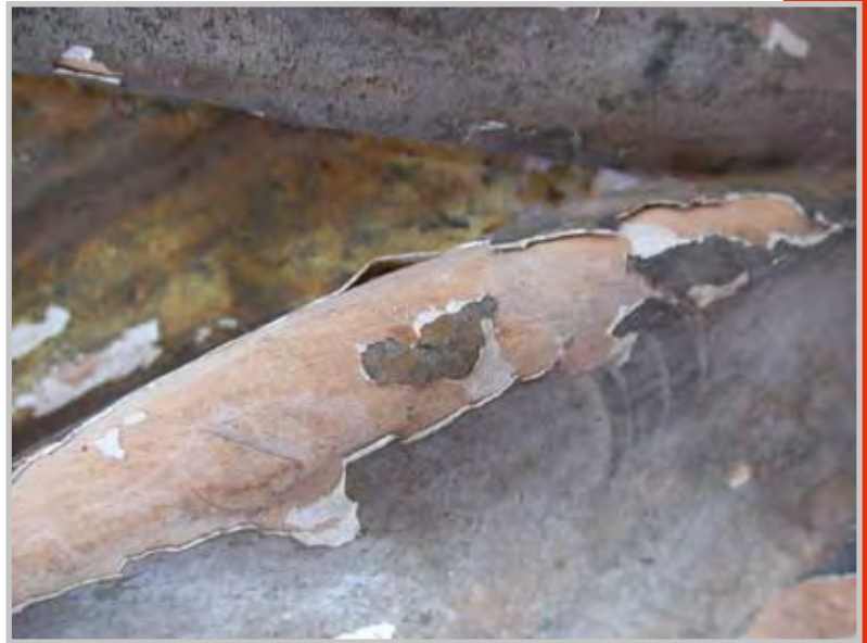
Schadensbild an einer Fassung Foto: Jenny Kretschmer
